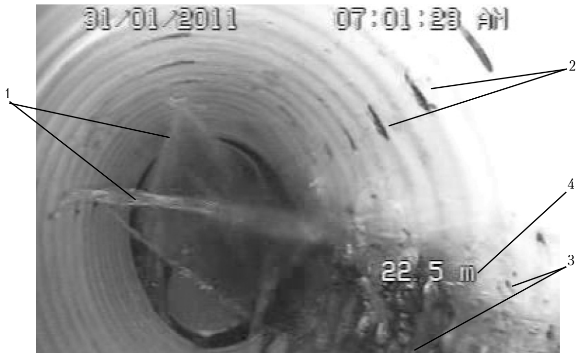
Рис. 9. Напірна фільтрація ґрунтової води у дрена: 1 – струмені води; 2 – дренажні отвори; 3 – низ труби; 4 – пісок
